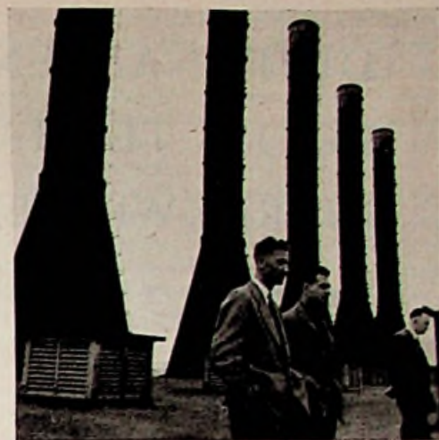
Even uitblazen op het dak met de afvoerpijpen als decor.
